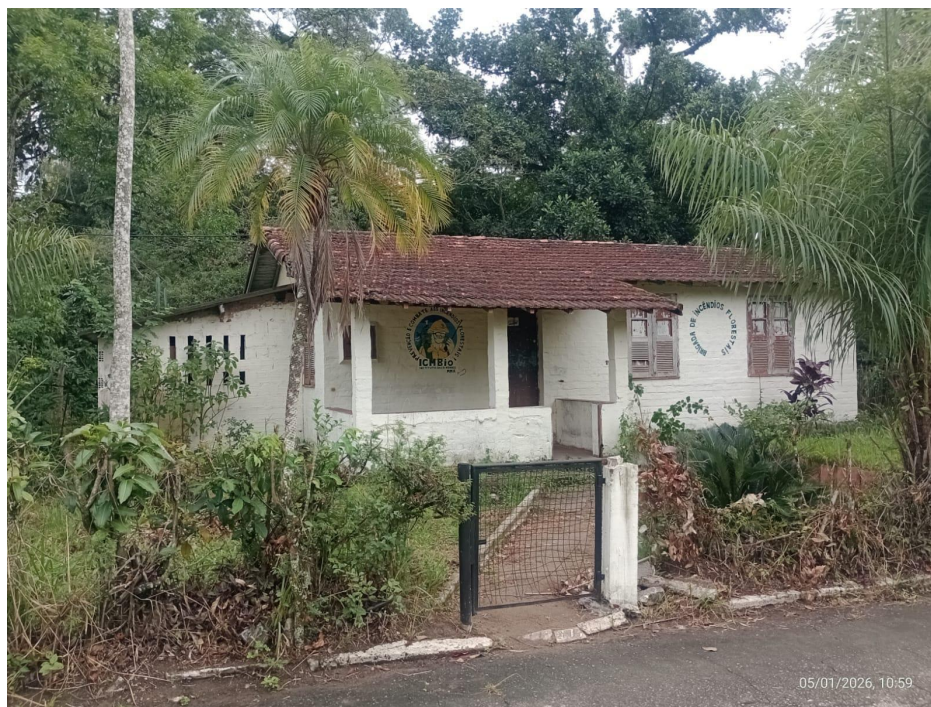
Figura 4: Antiga casa de operário, que hoje funciona a brigada de incêndios florestais. (Criação própria, 2026).
