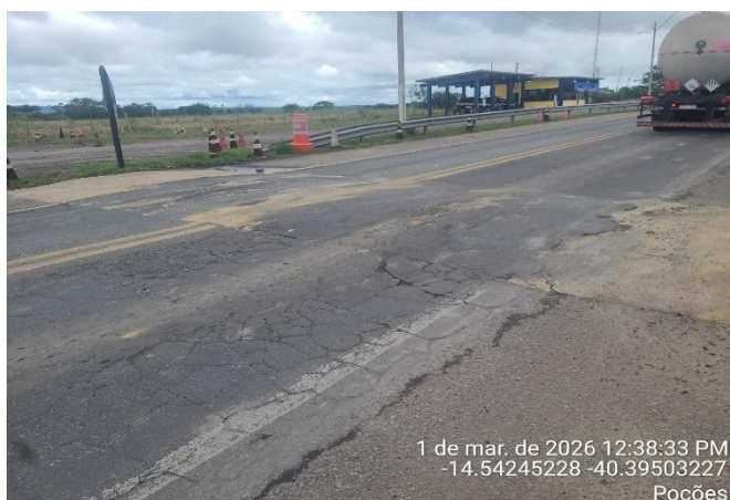
Figura 2 - Registro fotográfico antes da fresagem.
