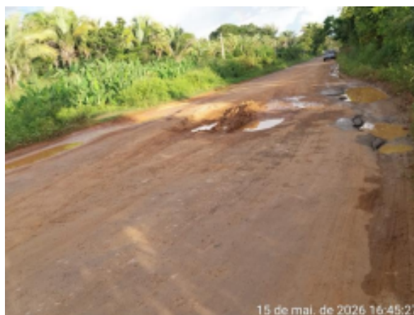
Figura 7 - Exemplo da Patologia buracos (panela)
