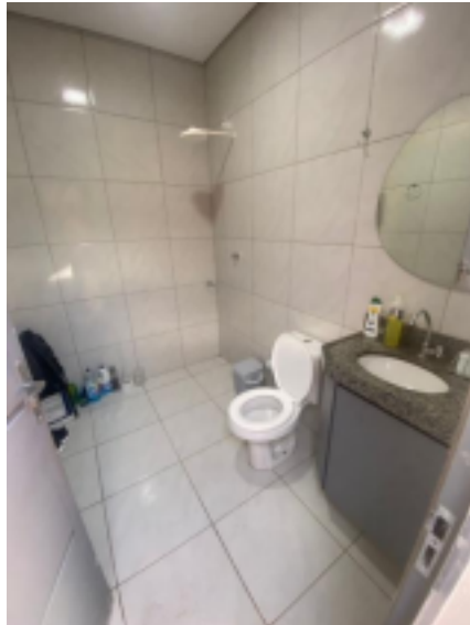
Figura 1 – Visão geral do banheiro feminino do canteiro de obras
