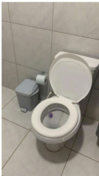
Figura 2 – Bacia sanitária do banheiro feminino
