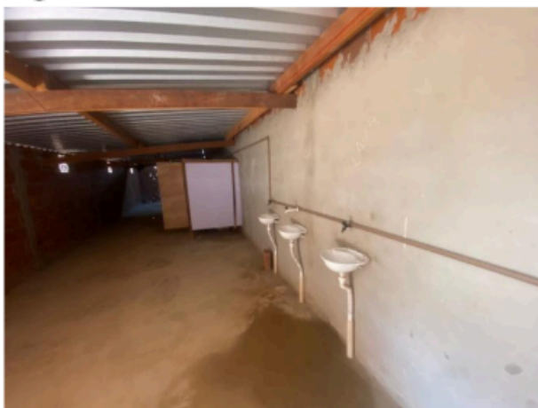
Figura 5 - Lavatório do banheiro masculino
