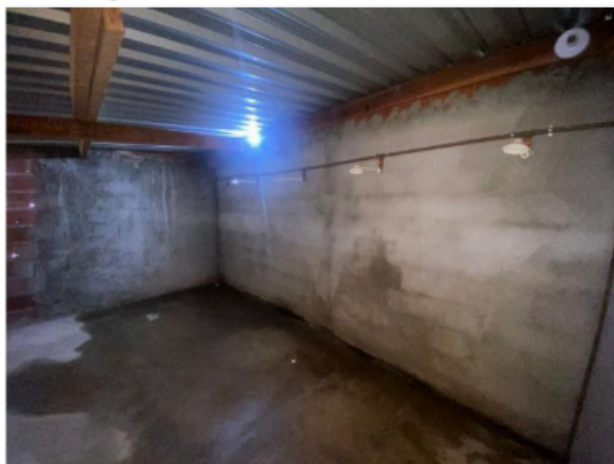
Figura 7 - Chuveiros do banheiro
