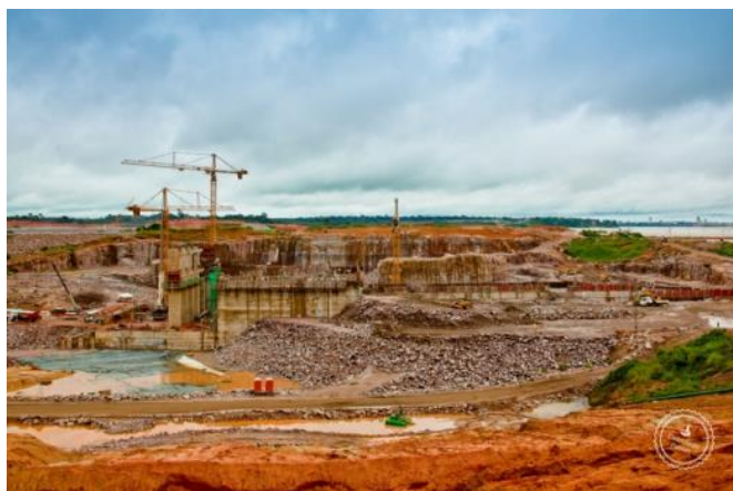
Figura 2 – Construção da UHE Santo Antônio.
