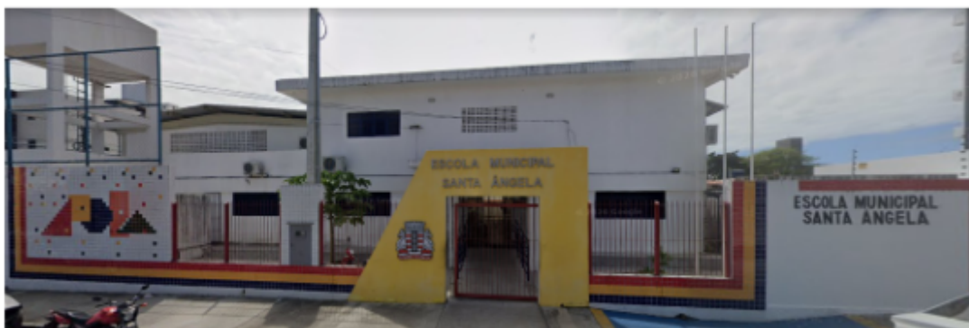
Imagem 1 - Escola Municipal Santa Ângela
