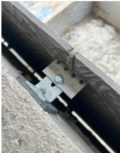
Figura 1 - Placa de revestimento com fixação de insert metálico.
