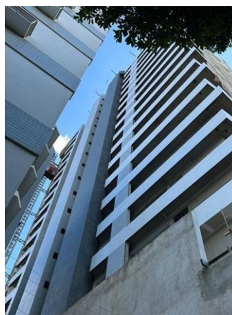
Figura 6 - Fachada lateral esquerda do edifício modelo.
