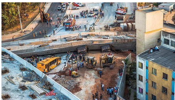
Fig. 1. Viaduto dos Guarapes em Belo Horizonte após desabamento.
