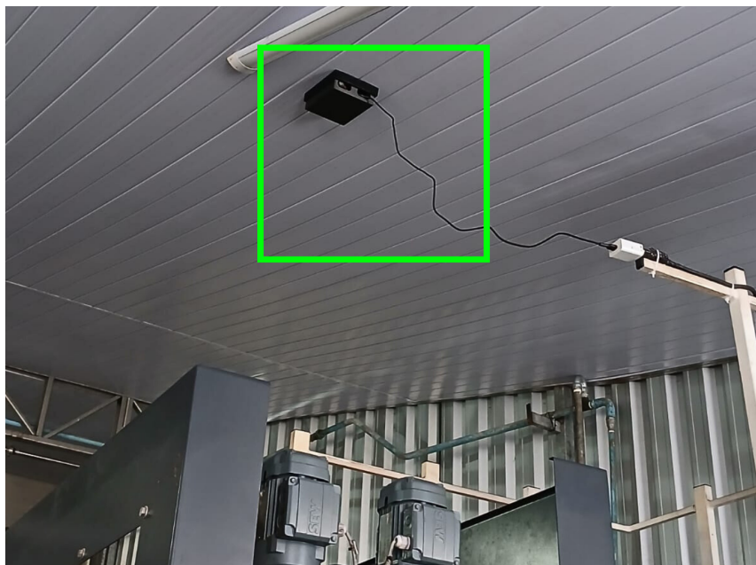
Figura 2 - Hardware de coleta de imagens de pacotes.
