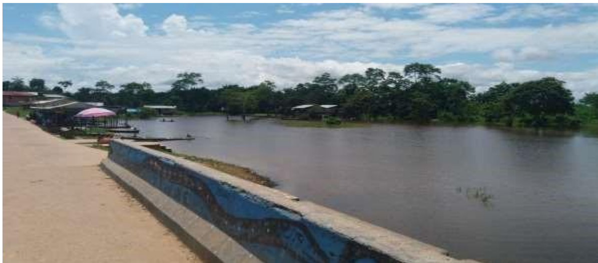
Fig.8: PONTE DE CONCRETO SOB O RIO SOLIMÕES QUE LIGA A COMUNIDADE DE UMARIAÇU I À UMARIAÇU II
