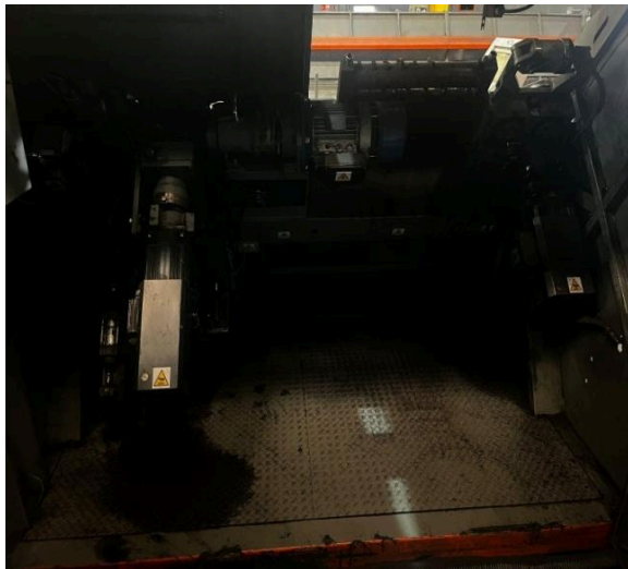
Figura 6- Estrutura inferior- Depois.
