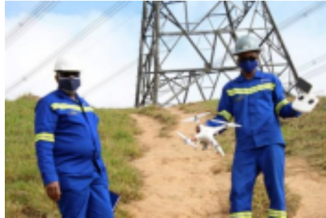
Figura 1: Inspeção de linha de transmissão com utilização de drone
